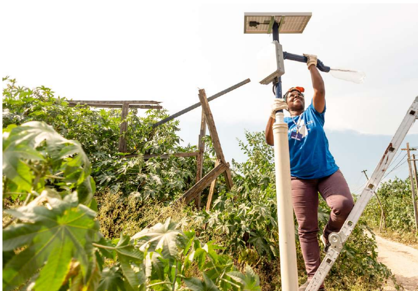
Instalação de um poste no Jardim Gramacho, Duque de Caxias/RJ.
